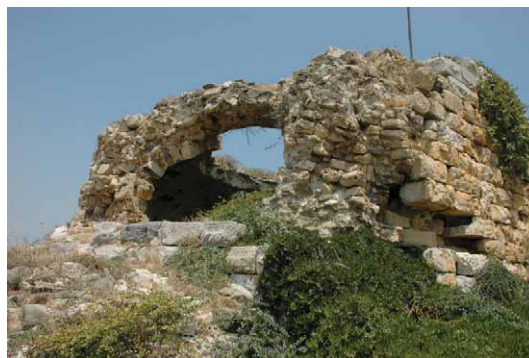
Figure 14 – Location A, West side, General view. Slika 14 – Pogled na zapadnu stranu konstrukcije A.
