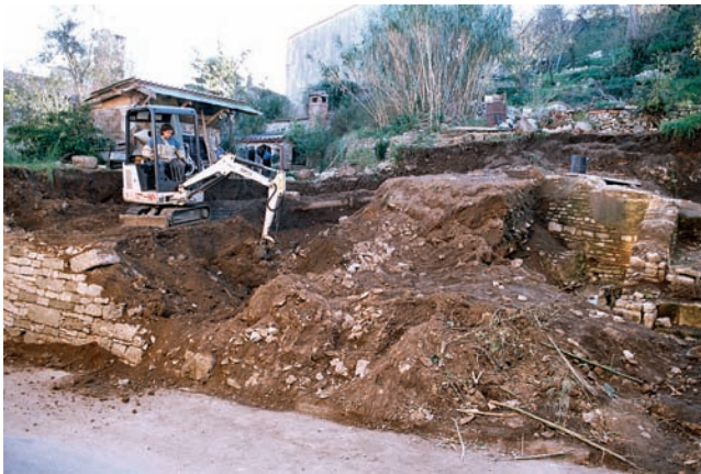
Sl. 2 Pogled na iskop humusnog sloja u području vrta u sektorima E i F kao i na djelomično iskopane antičke, kasnoantičke i srednjovjekovne arhitektonske elemente (zidovi, i rampa)
