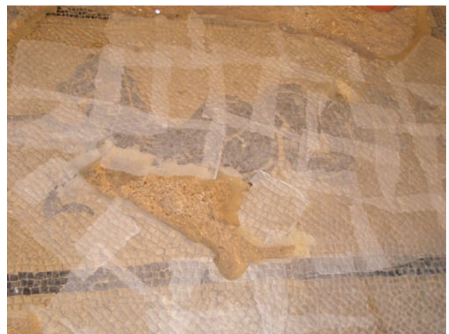
Sl. 7 Podljepljivanje kritičnog dijela Fig. 7 The application of glue on the nether section of the critical area
