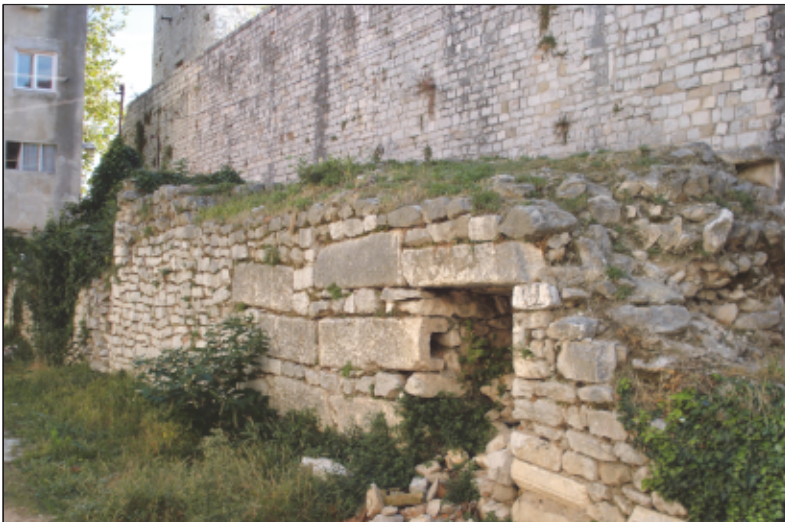
Sl. 16. Segment kasnoantičkog gradskog zida pred zgradom “Dječjeg dispanzera” s pogledom na pravokutni otvor (vrata?) i spolije od kojih je zid građen (snimila V. Jović)
