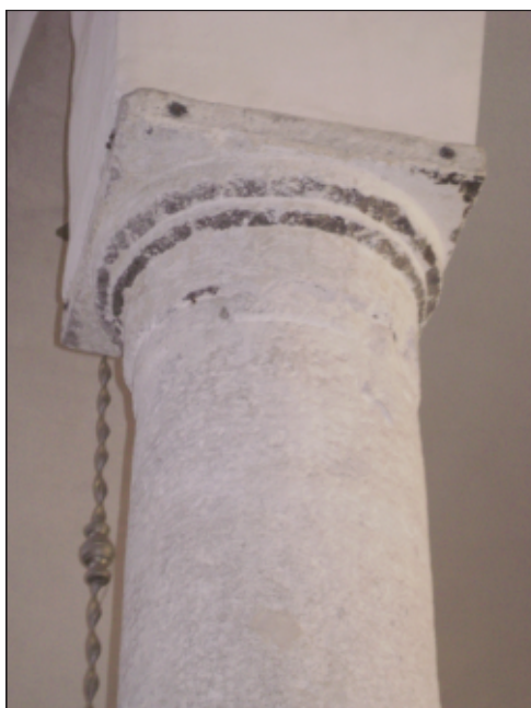
Sl. 17. i 18. Pogled na sjevernu kolonadu i detalj stupa južne kolonade bazilike sv. Stjepana
