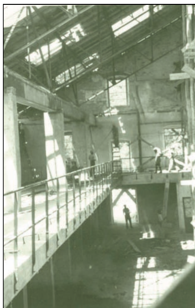
Sl. 7. i 7.a Unutrašnjost Arsenala s vidljivim ranijim pregradnjama i kasnijom armirano-betonskom konstrukcijom (Arhiv Konzervatorskog odjela u Zadru)
