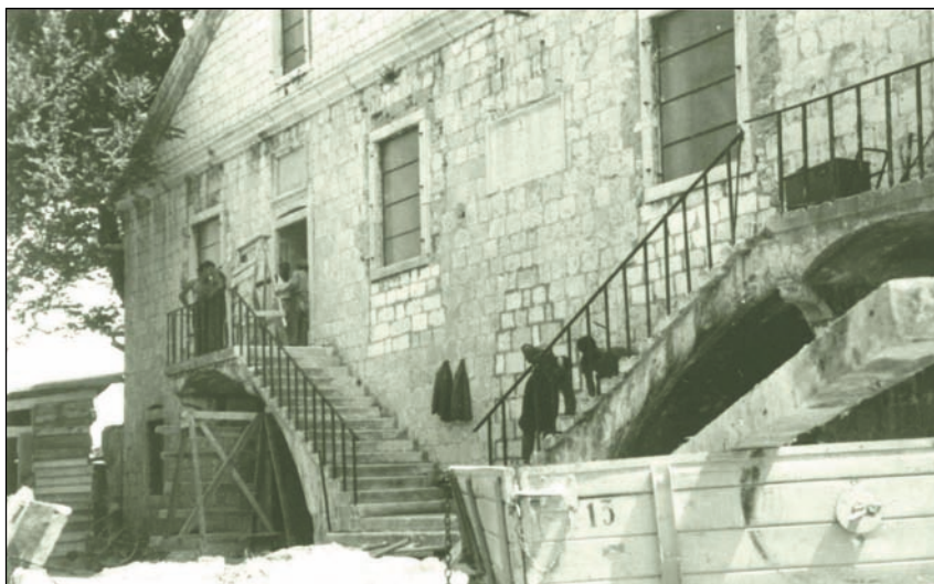
Sl. 8. i 8.a Pročelje Arsenala za vrijeme obnove s još uvijek otvorenim srednjim vratima u prizemlju i nakon njihova zatvaranja (Arhiv Konzervatorskog odjela u Zadru)
