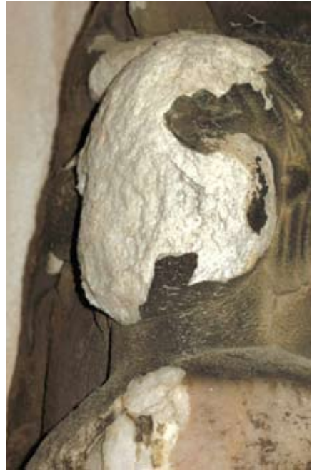
Izmjenični procesi sušenja i kristalizacije soli prouzročili su oštećenje pojedinih likova do neprepoznatljivosti
