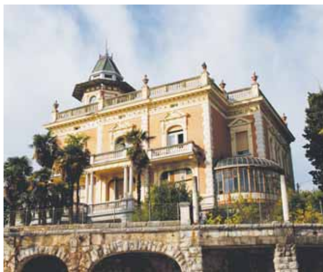
5 Vila Münz, Ičići, uzmorsko pročelje, 2009. (foto: I. Žorž) Villa Münz, Ičići, sea facing facade, 2009
