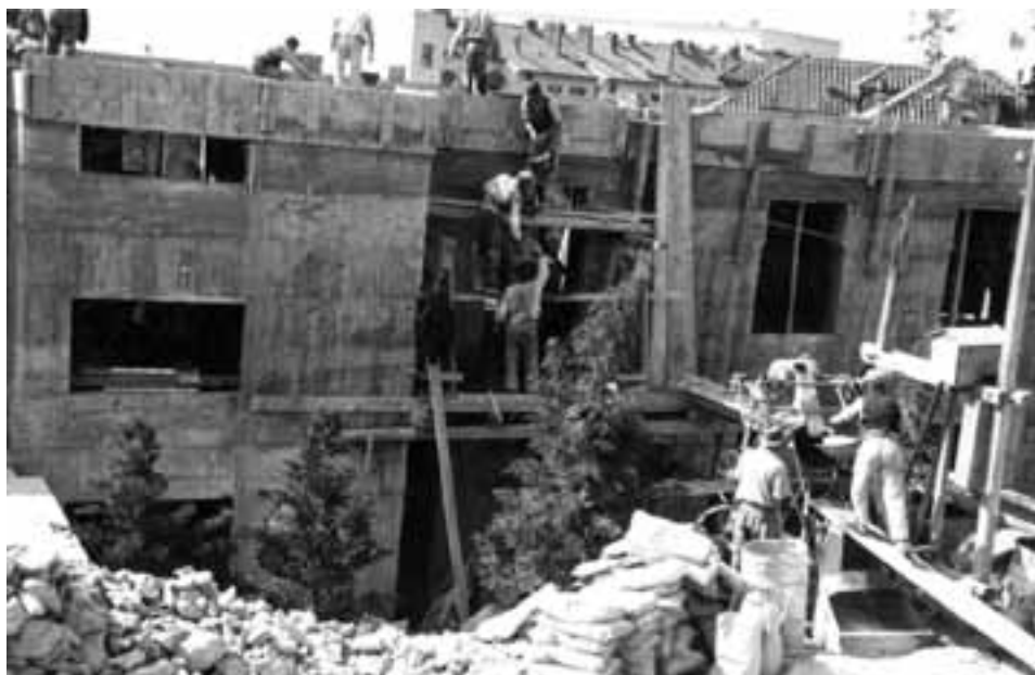
slika 10. Gradnja stambeno-poslovne zgrade Lloyd's Register of Shipping
