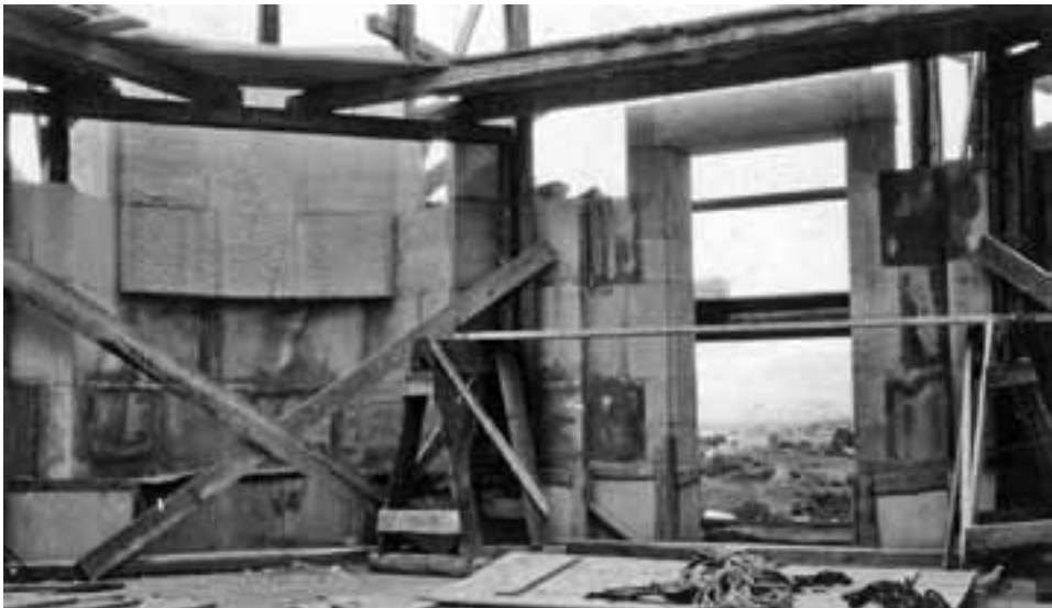
slika 5. Gradnja Meštrovićeva mauzoleja u Otavicama
