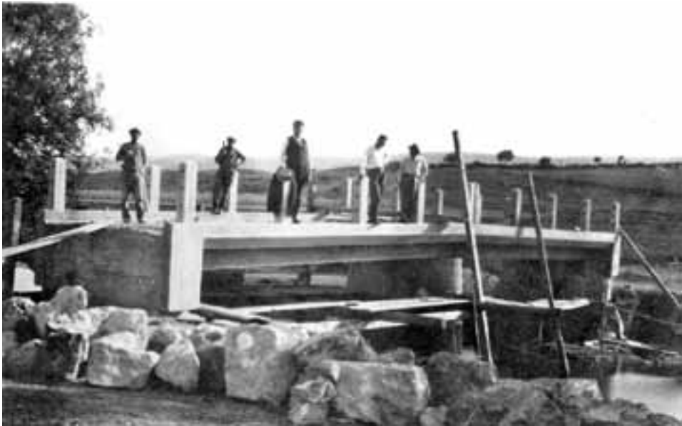
slika 4. Gradnja mosta preko rijeke Čikole
