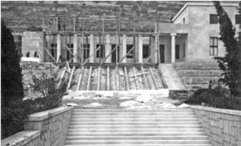
slika 3. Gradnja Galerije Meštrović u Splitu
