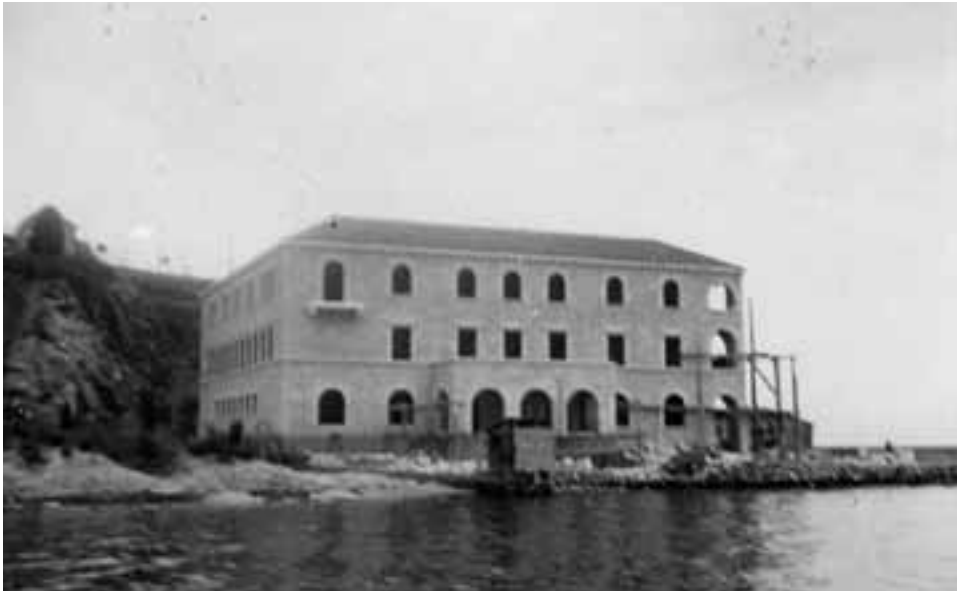
slika 2. Gradnja Biološko-oceanografskog instituta na rtu Marjana u Splitu
