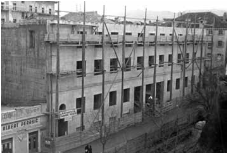
slika 8. Gradnja zgrade Pošte u Splitu
