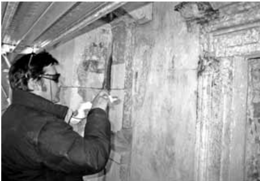
slika 1. Lasersko čišćenje
