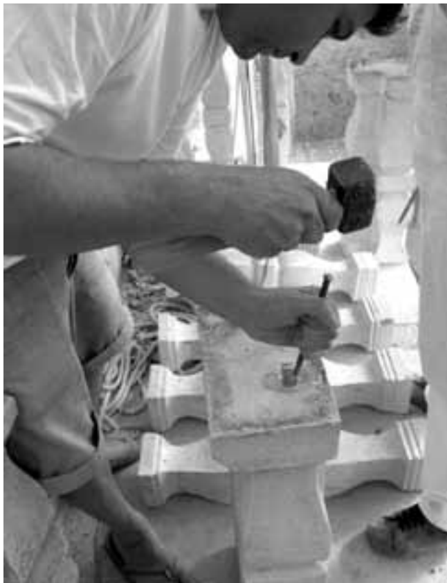
slika 6. Montaža balkona
