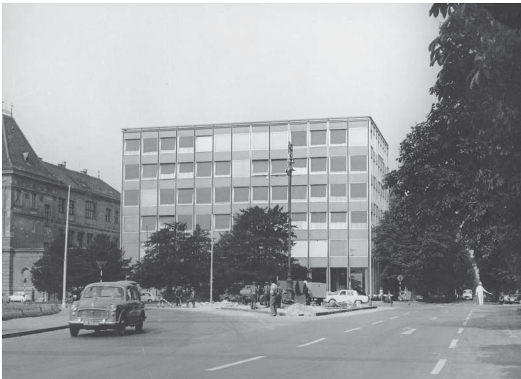
11 Stanko Fabris, Pogled na poslovnu zgradu »Željpo« – istočno – ulično pročelje, Trg maršala Tita, fotografija izvornog stanja, Jozo Vranić, 1968., vrijeme obnove HNK (fototeka Muzeja grada Zagreba, inv. br. 9952)
