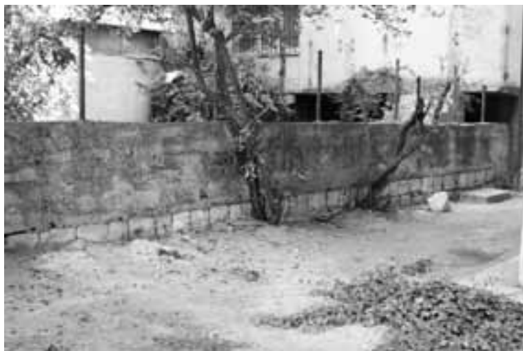
Nastavak zidane konstrukcije u dvorište susjedne zgrade
