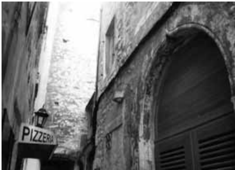
Tri niše nepravilnog oblika na dvokatnici od priručno lomljenog kamena i s nepravilnim fugama u Židovskom prolazu
