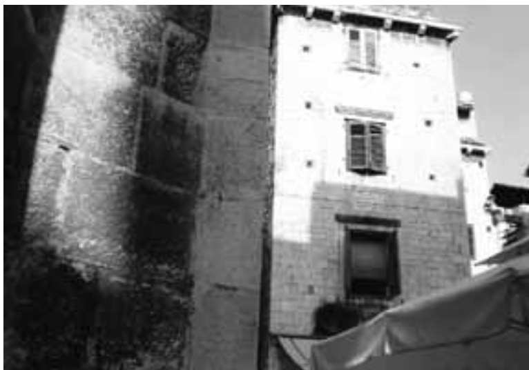
Niše na kamenom zidu dviju zgrada zapadnog sklopa na Poljni Grgura Ninskog s neuobičajenim okvirom od maltera
