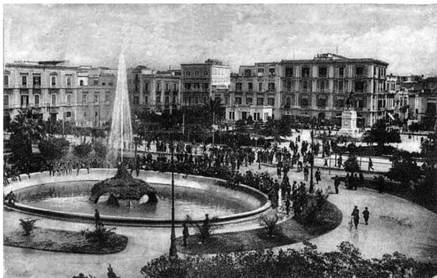
Bari, Piazza Ateneo, la prima fontana dell'Acquodotto Pugliese inaugurata in Bari il 24 aprile 1915.
