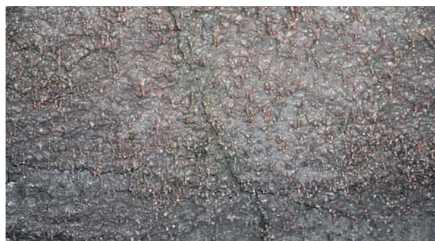
Slika 6: Krovina tunela Leiðarendi
