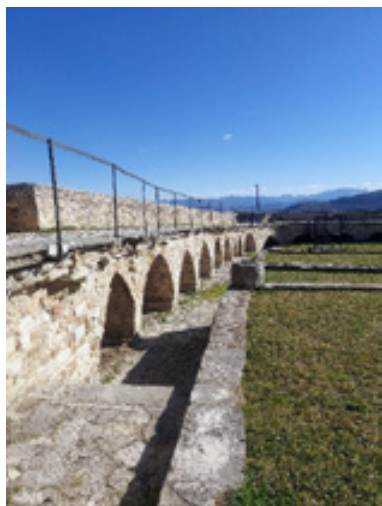
Sl. 5 – Kazamati sjevernoga zida
