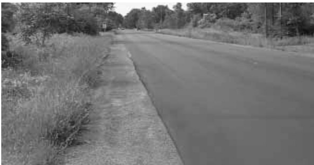
Slika 6. Asfalt izgrađen od čeličanske troske
