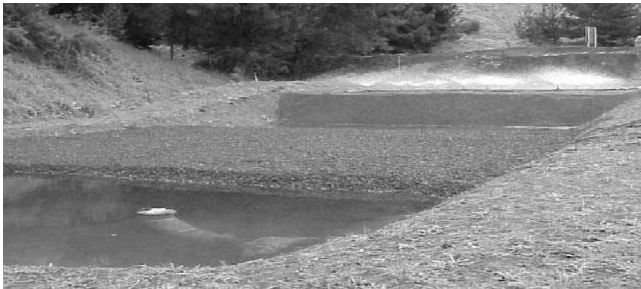
Slika 5. Korištenje troske za regulaciju vodotoka
