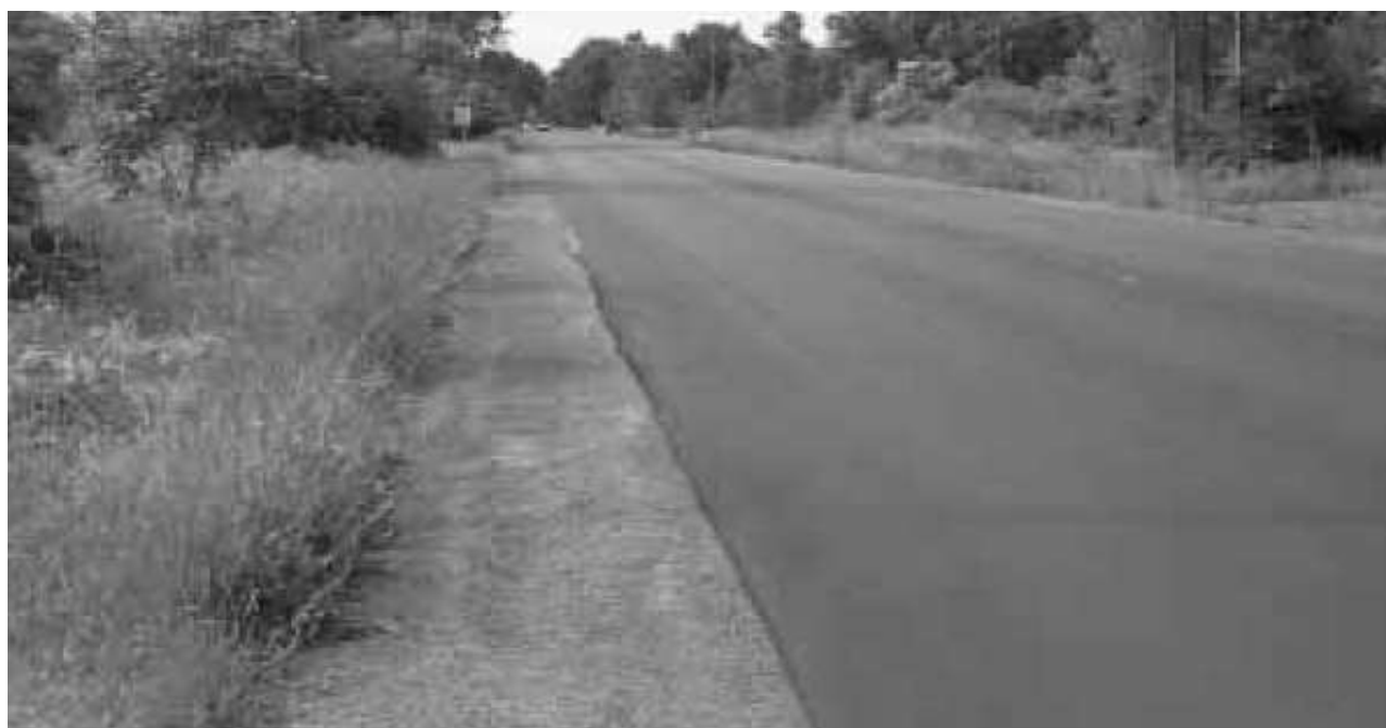
Slika 6. Asfalt izgrađen od čeličanske troske
